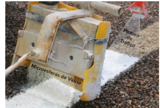
Microesferes de vidre de la pintura vial, procedents de reciclat
