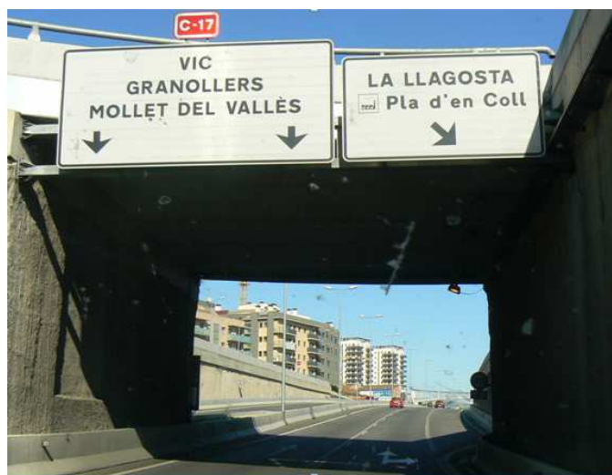
Sortida del túnel a Mollet. Inici de la variant de la C-17
